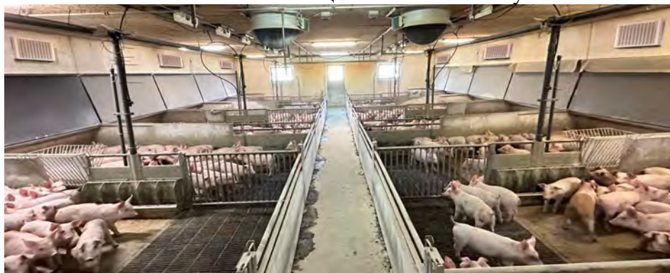
Стельова система вентиляції
